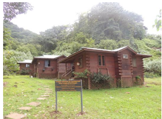
Complejo habitacional de Guardaparques
