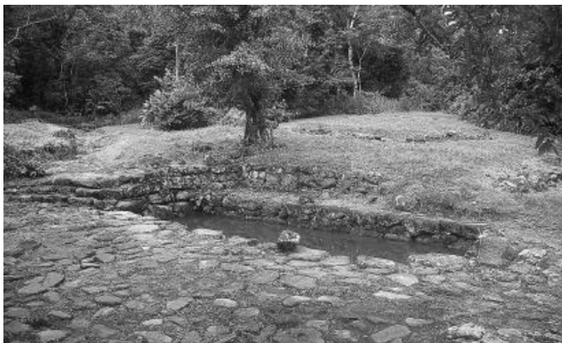
Tanque de captación de agua del acueducto
