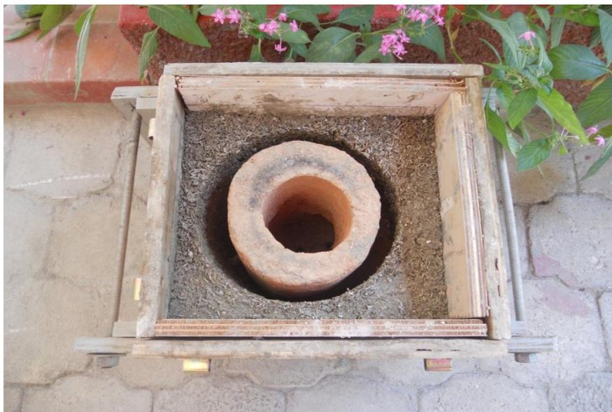
**Figura 10:** Mezcla de cemento y cáscara de arroz rodeando la cámara de combustión dejando espacio.
