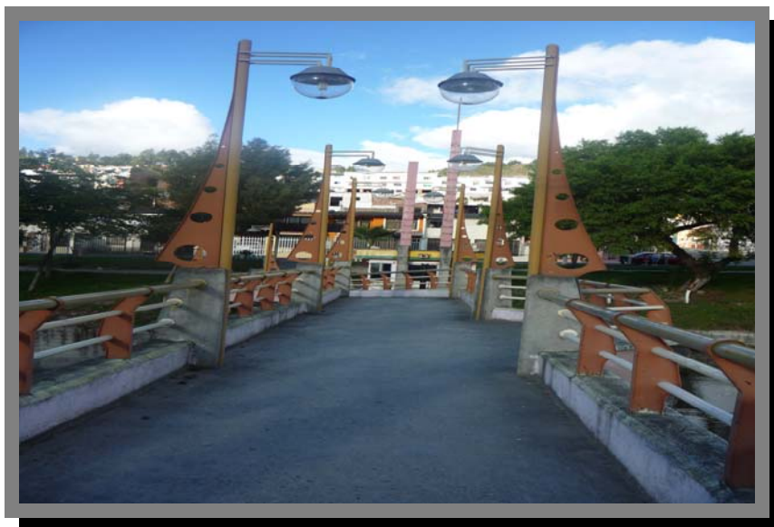
Figura 51. Puente que une el Parque Lineal con el Barrio Los Geranios (María Reinoso 2010)
