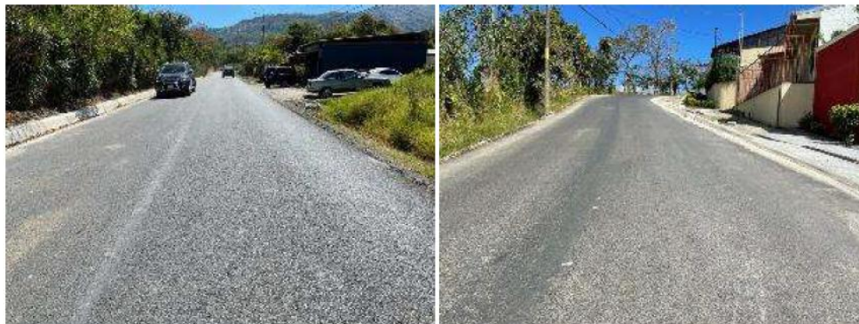
Figura 5. Acabado final del camino
