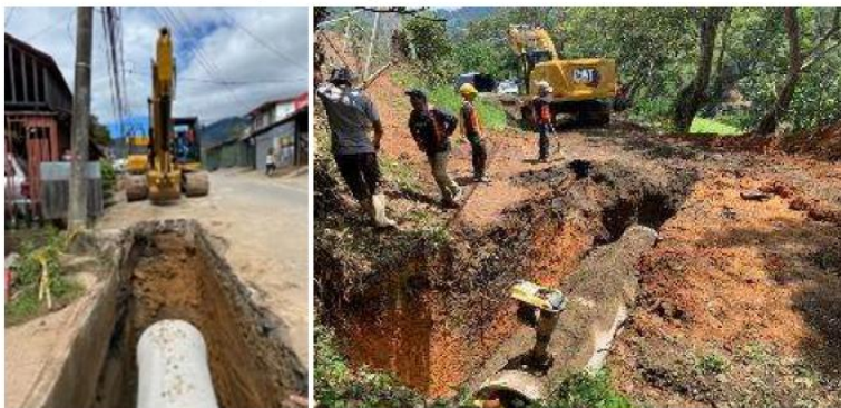
Figura 3 Colocación de tubería. Estaciones 0+100 y 3+786
