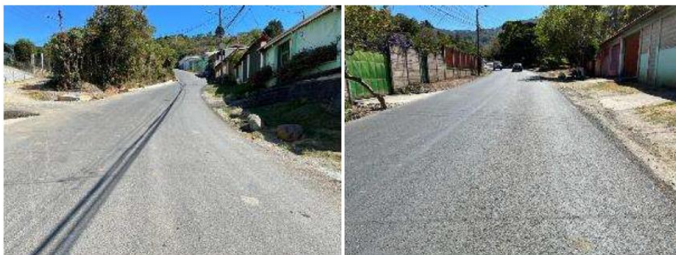
Figura 4. Acabado final del camino
