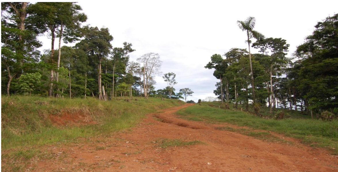
Figura 73: Efectos erosivos causados por construcción vial.
