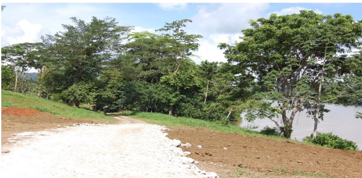
Figura 21: Distancia de carretera en construcción al río San Juan.
