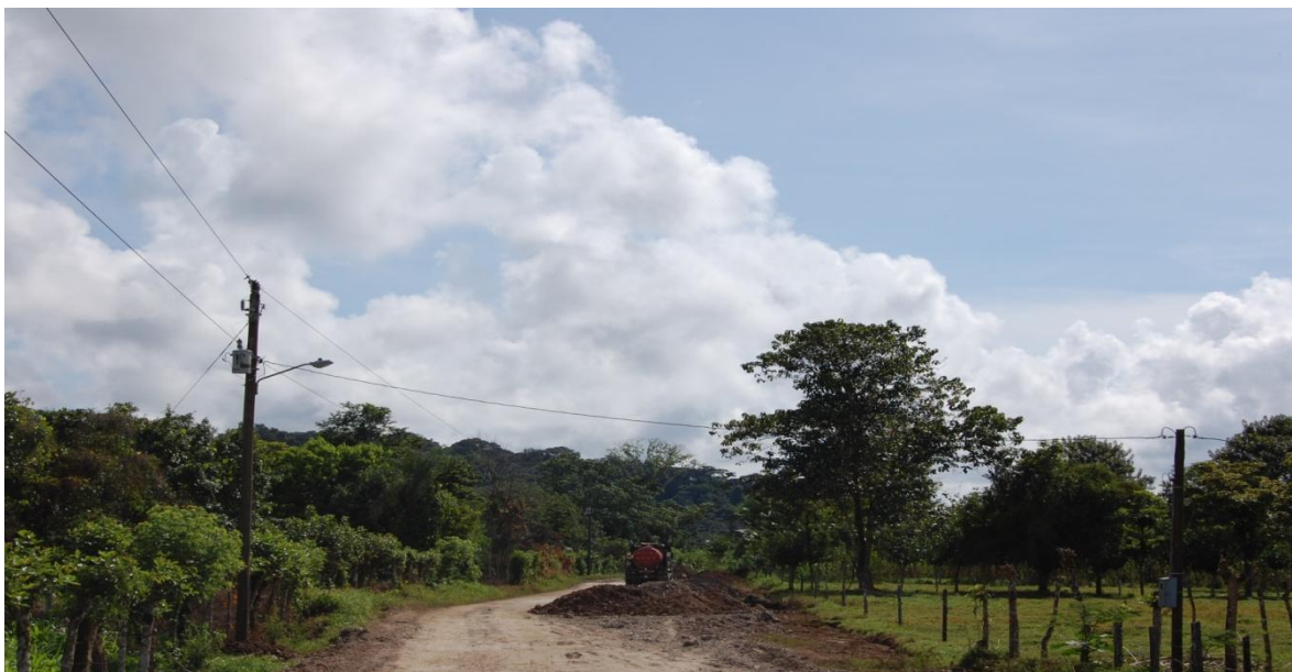
Figura 77: Tendido líneas eléctricas.
