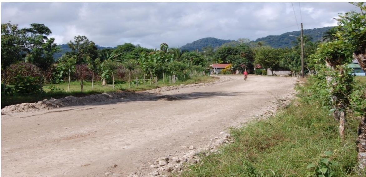
Figura 76: Carretera en construcción Boca San Carlos
