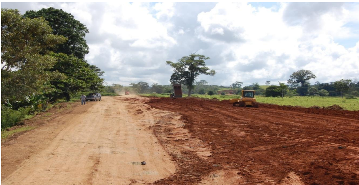
Figura 83: Movimiento de tierra por acción constructiva.
