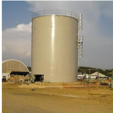
Figura 4 Tanque Pre-fabricado en acero (Fuente: HEDAGA S.A )
