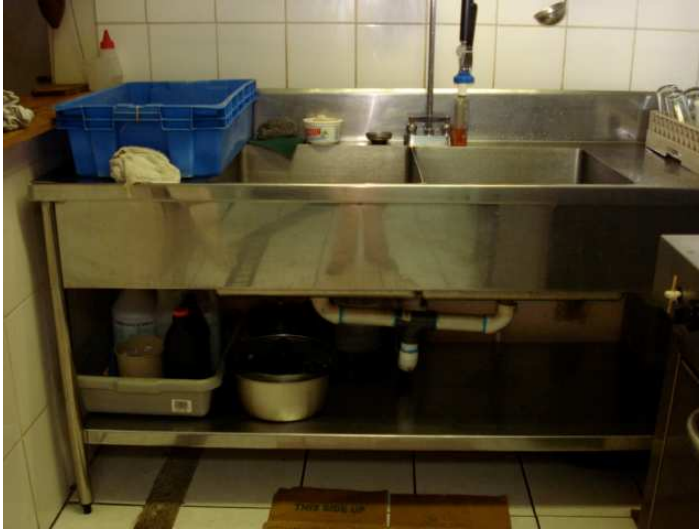
Figura #35 Fotografía -Pila (almacenamiento de productos químicos)
