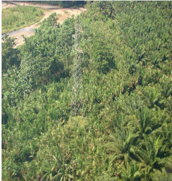
Figura N° 11: Cultivo de palma aceitera ubicado en la servidumbre de la línea de transmisión Río Claro-Paso Canoas.
