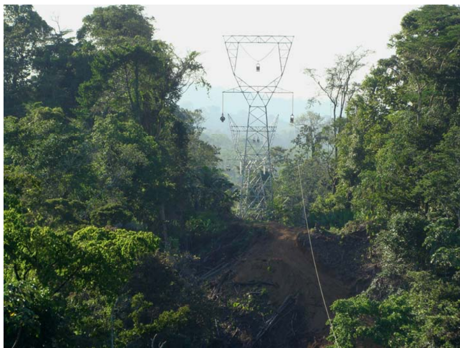
Figura N° 7: Eliminación de bosque secundario para dar paso a una línea de transmisión de alta tensión, sector Limón.
