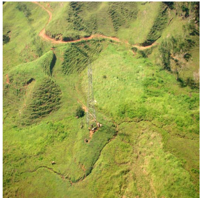
Figura N° 5: Ganadería extensiva que se desarrolla cerca de la torre N° 117, línea de transmisión San Isidro-Río Claro.
