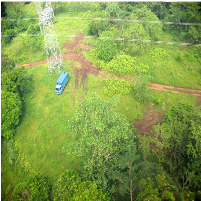
Figura N° 4: Potreros arbolados presentes en la línea de transmisión General-Lesville.
