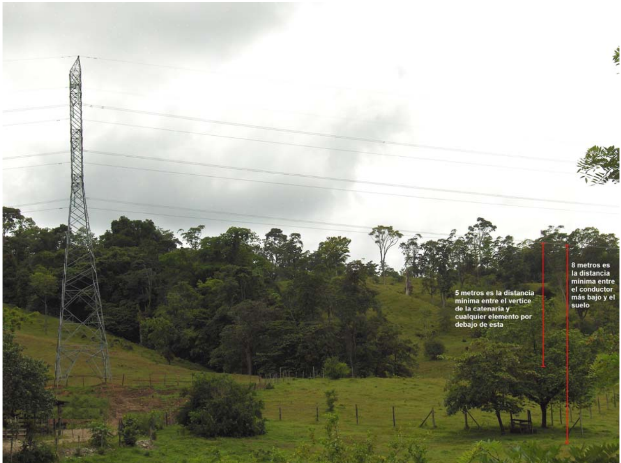
Figura N° 2: Límites de seguridad establecidos entre los conductores y la vegetación que se desarrolla debajo de la servidumbre de la línea de transmisión de alta tensión Siquirres-Limón (Arias, 2008).
