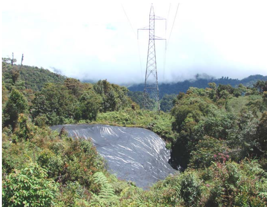
Figura N° 16: Colocación de plástico para evitar la erosión del suelo entre torres N° 21 y 22, de la línea de transmisión Río Macho-San Isidro.
