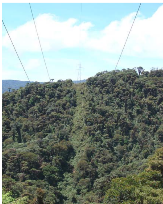
Figura N° 6: Corta de la vegetación para dar mantenimiento a las servidumbres de las líneas de transmisión de alta tensión, Parque Nacional Macizo de la Muerte.
