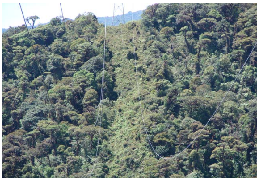
Figura N° 15: Línea de transmisión en la cual los conductores pasan muy alto de la vegetación permitiendo el desarrollo completo de la misma.
