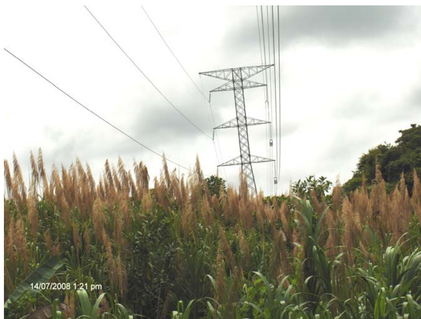
Figura N° 12: Cultivo de caña ubicado a la par de la estructura N° 36 de la línea de transmisión Siquirres-Limón.
