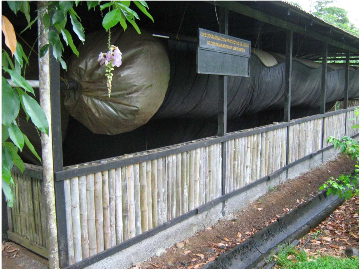
Figura 19. Biodigestor de flujo continuo instalado en la finca pecuaria de la Universidad EARTH. Guácimo de Limón. Costa Rica. Se muestra la campana de almacenamiento de biogás. 2009.
